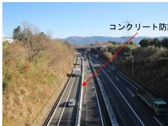
【コンクリート防護柵運用状況】
