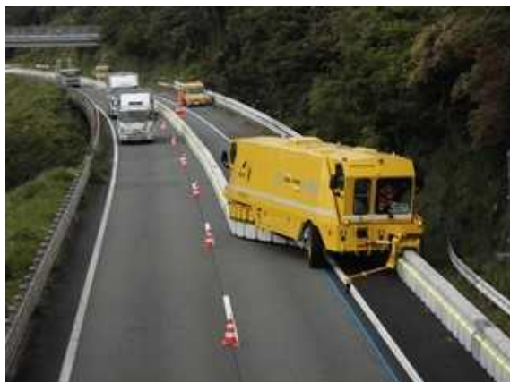
【移動式防護柵（Road Zipper System）の作業状況】
