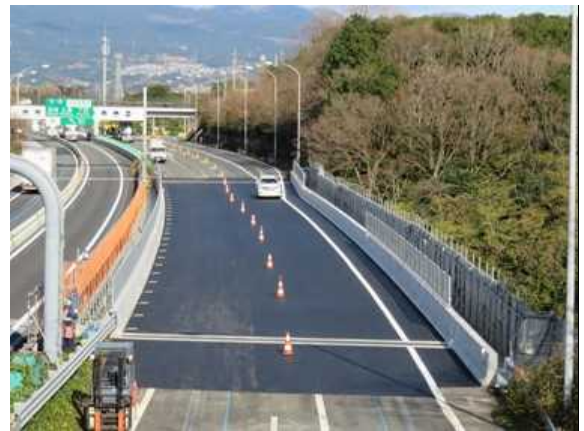
【愛鷹橋の床版取替え完了（2020年3月9日）】
