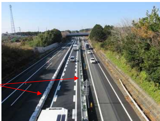
【置き式ガードレール設置状況】
