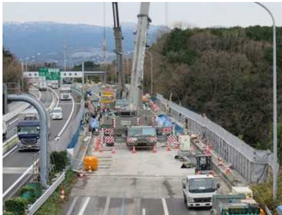
【愛鷹橋の床版取替え状況（2020年1月27日）】
