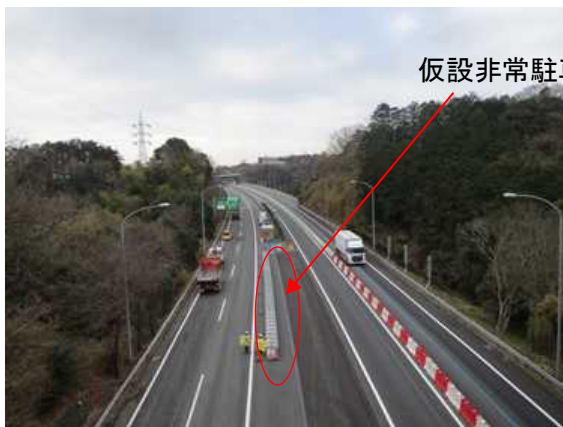
【仮設非常駐車帯設置状況】
