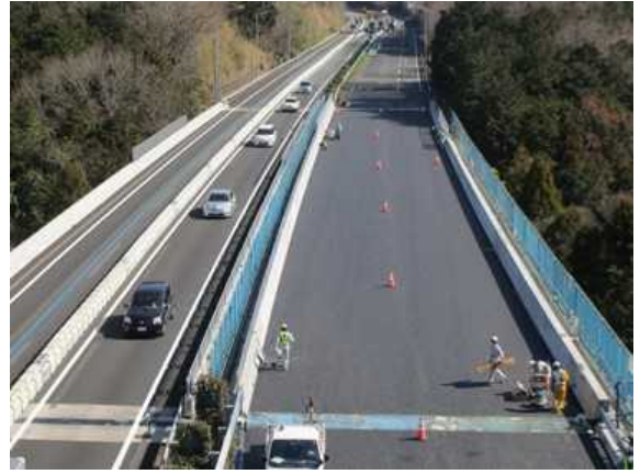
【下長窪橋の床版取替え完了（2020年3月9日）】
