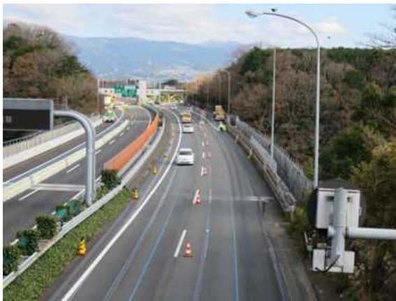
【愛鷹橋の床版取替え前（2020年1月6日）】
