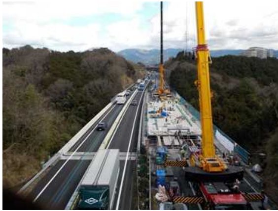
【下長窪橋の床版取替え状況（2020年1月31日）】
