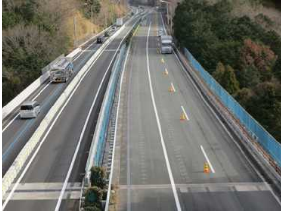
【下長窪橋の床版取替え前（2020年1月16日）】
