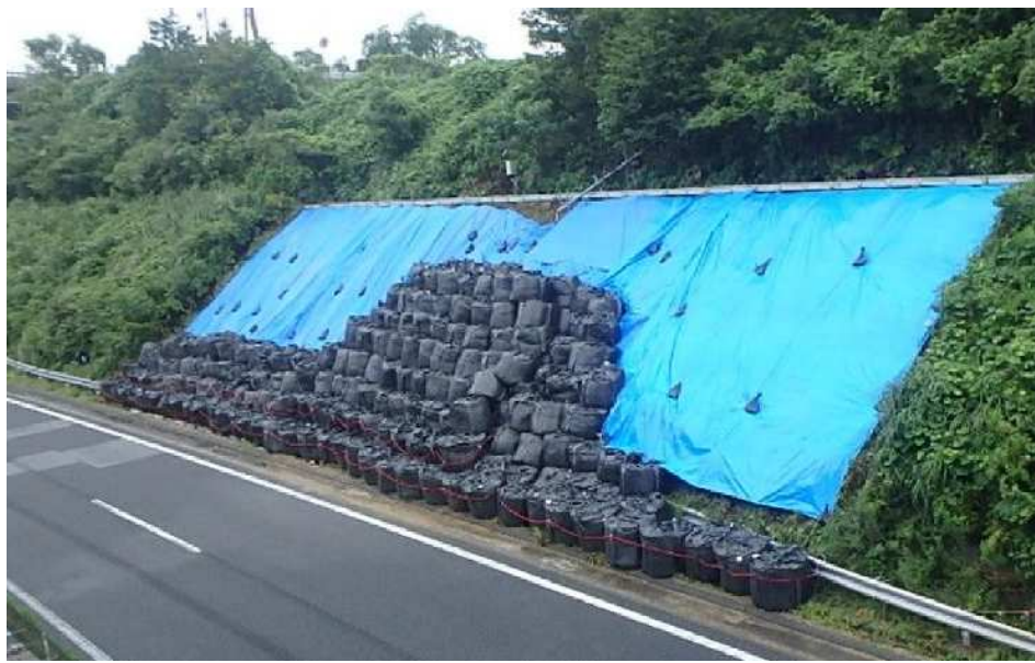
のり面災害発生後の災害応急復旧作業
