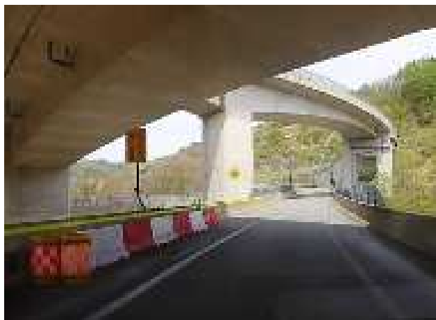
【仮設防護の設置】
