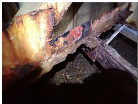
【鋼橋の腐食】
