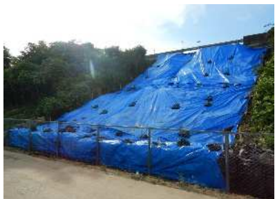
【応急復旧状況】
