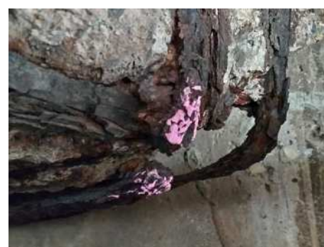
【鉄筋の破断】
