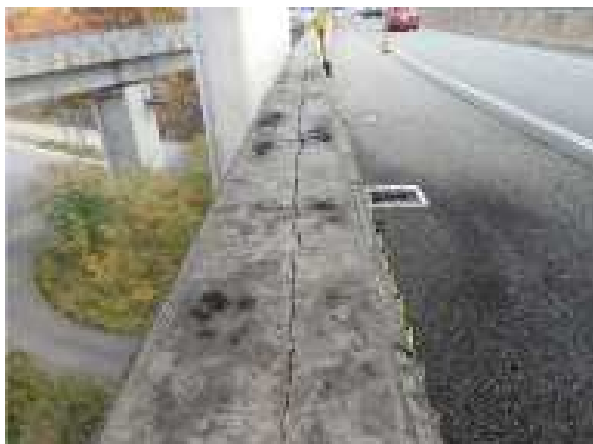
【壁高欄のひび割れ】
