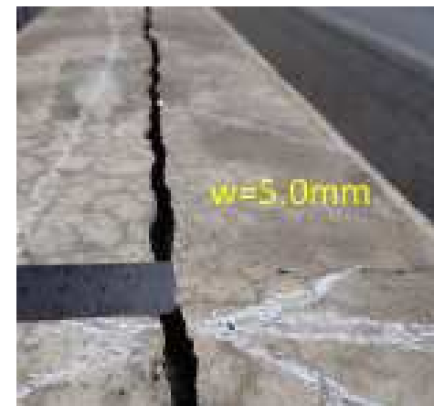
【壁高欄のひび割れ】
