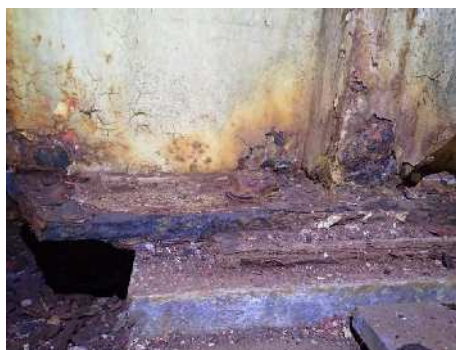
【鋼橋の腐食】
