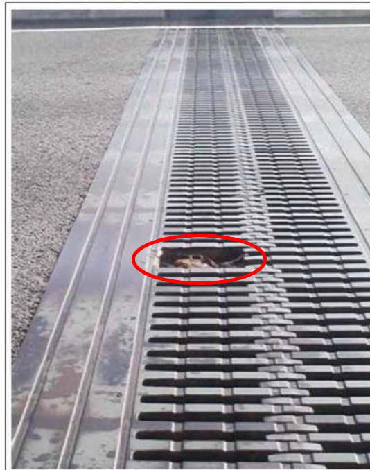
損傷事例（左：ビーム型 右：フィンガー）
