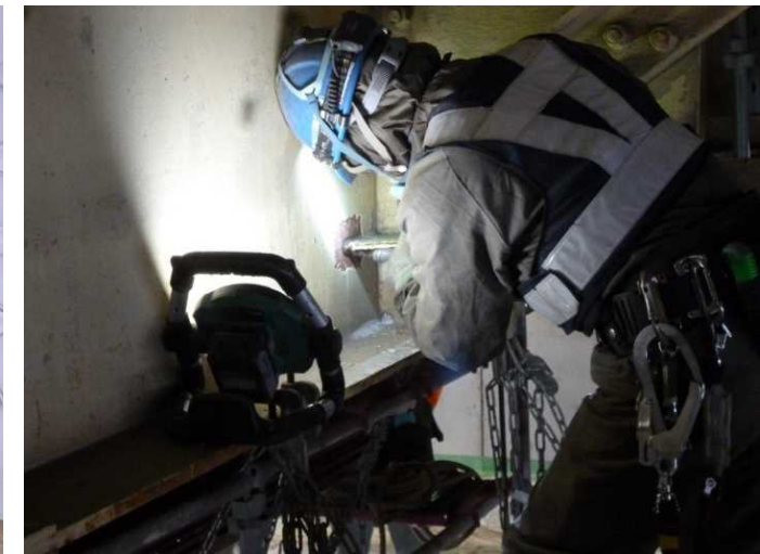
溶接止端仕上げ
