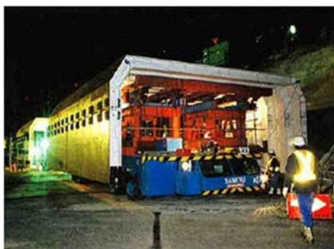
写真 2.1 防護工運搬車両
