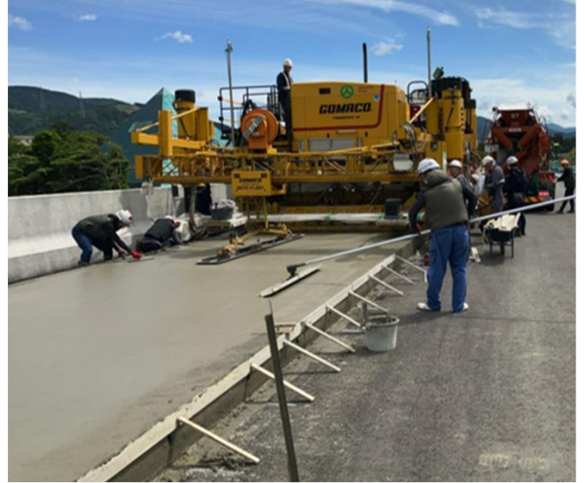
連続鉄筋コンクリート舗装版 施工状況(小山町域)
