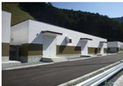
トンネル電気室
