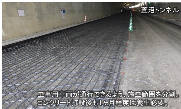
連続鉄筋組立状況
