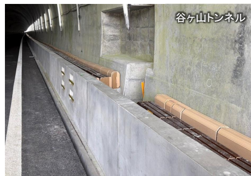
監視員通路 施工状況
