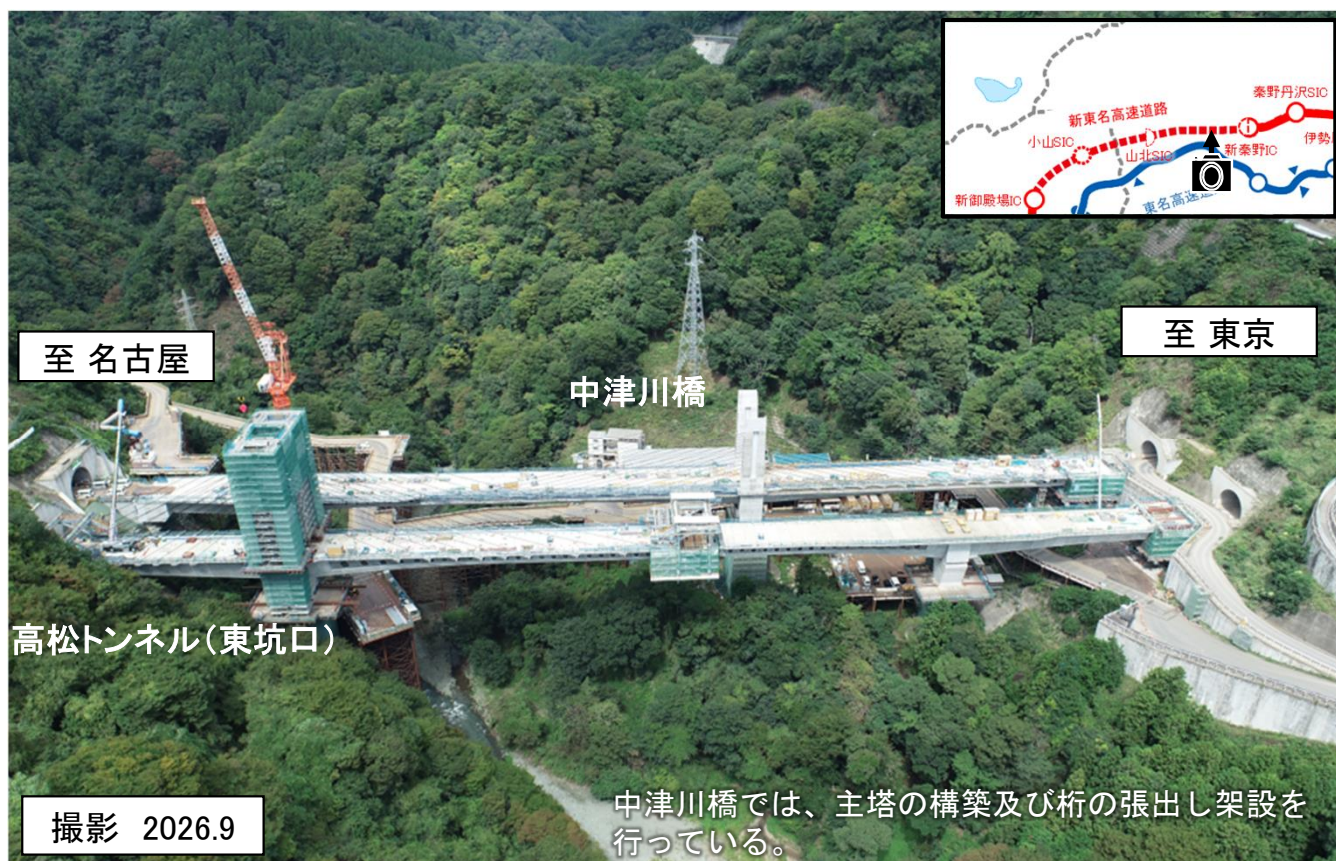
中津川橋※付近（松田町域）
