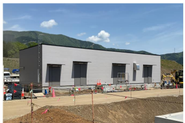
トンネル電気室施工状況(小山町域)
