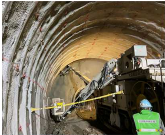
城端トンネル 掘削状況
