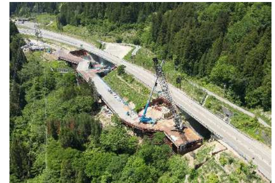
シクタンナ橋、ゾウソウ橋（下部工）施工
