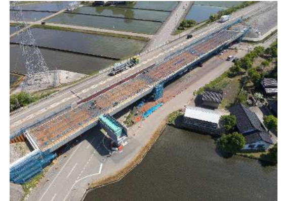
竹林高架橋（上部工）施工
