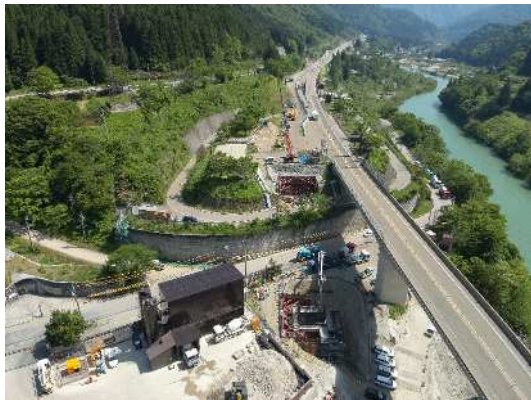
五箇山橋（下部工）施工
