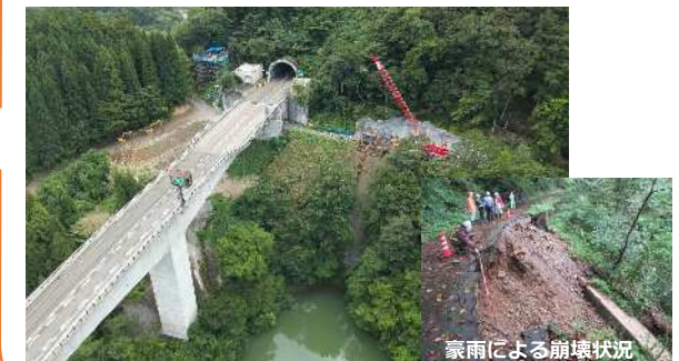
小白川トンネル 工事用道路施工
