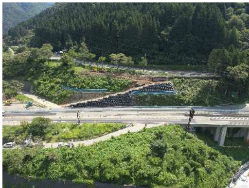
五箇山IC付近 本線脇斜面部掘削
