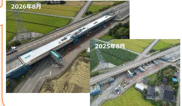
竹林高架橋（上部工）施工
