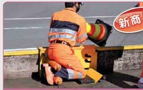
規制作業用の転落防止安全装置
