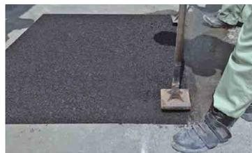
⑤スコップやタンバ、ピフロプレートなどで充分に締め固めます。
