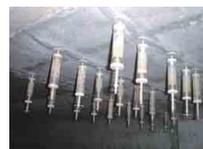
従来工法（低圧注入工法）
