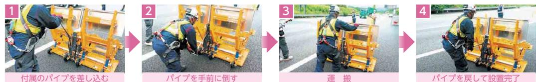
付属のパイプを本装置に差し込み、手前に倒すだけで移動状態を維持できます。運搬後はパイプを戻し脚を降下させ、設置状態に戻します。簡単な作業ステップで、運搬作業を効率的にサポートします。
