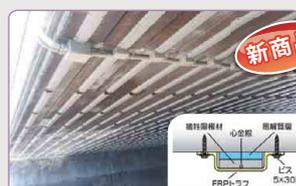
線状流電陽極ユニット方式電気防食工法
