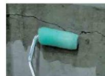
AT388（塗布浸透接着工法）
