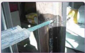
鋼構造物亀裂用・浸透エポキシ
