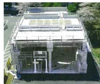
構造物点検の研修施設 N 2 U-BRIDGE
