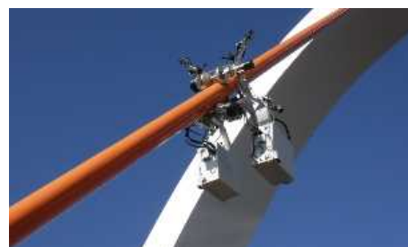
斜張橋ケーブルの点検ロボット
