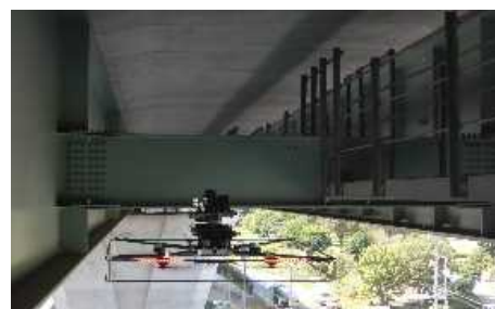
ドローン（無人航空機）で橋梁点検を支援
