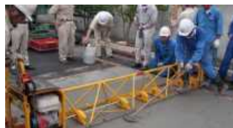
超高強度繊維補強コンクリートの試験施工
