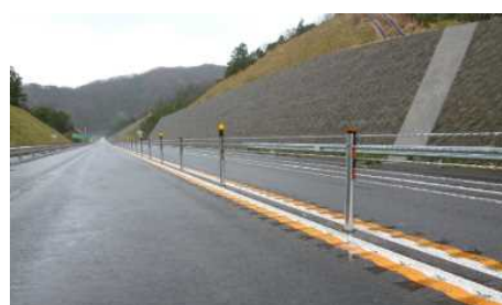
暫定2車線区間のワイヤロープ
