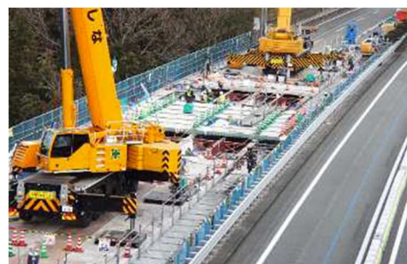
大規模更新工事での橋梁の床版取替
