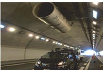
トンネル内の機器(ジェットファン、照明等)のずれを日常点検時に自動検出できるイメージスキャナを用いた技術の開発
