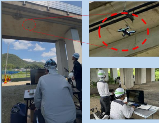
(リアルタイム動画点検の実施状況)
