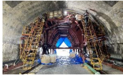
(トンネル修繕工事の状況)
