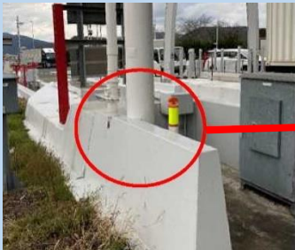
(トールゲートの柱へのプロテクター設置状況)
