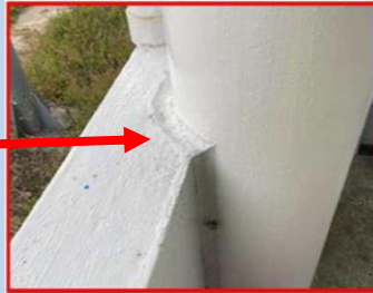
(トールゲートの柱へのプロテクター設置状況)
