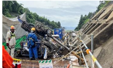
(土工構造物修繕工事の状況)
