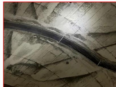
(漏水対策状況:樋設置)
