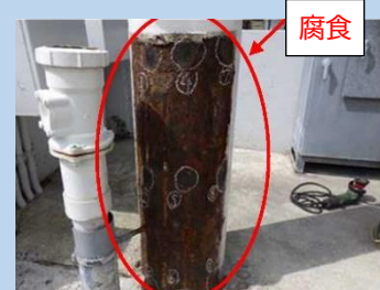
(プロテクター撤去後の柱の状況)
