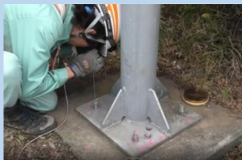
(非破壊検査など特殊技術が必要)
