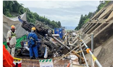
(土工構造物修繕工事の状況)
