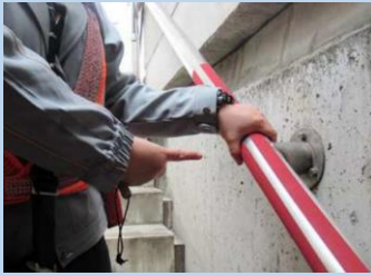
(滑り止めテープを設置)
