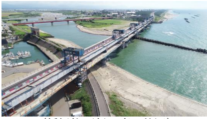
(橋梁桁更新工事の状況)
