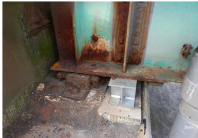
(判定区分Ⅲ 補修前)
