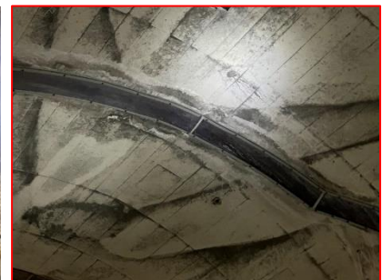
(漏水対策状況:樋設置)
