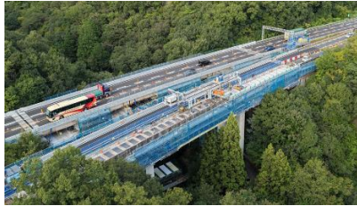
(橋梁床版更新工事の状況)
