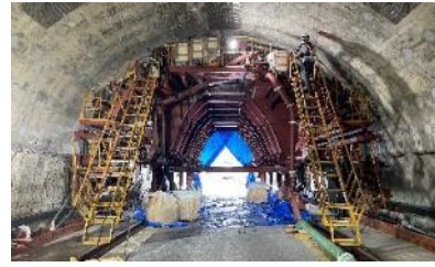
(トンネル修繕工事の状況)
