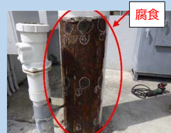
(プロテクター撤去後の柱の状況)
