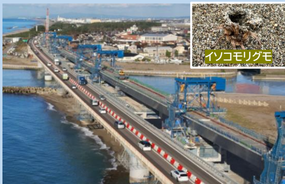
(新手取川橋の工事状況)
