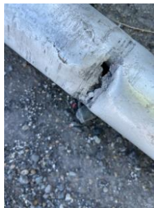
(支柱の損傷状況)
