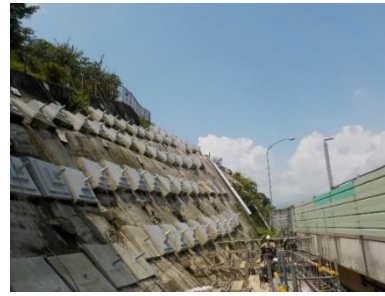
(グラウンドアンカー施工状況)
