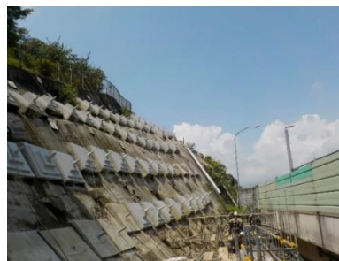
(グラウンドアンカー施工状況)
