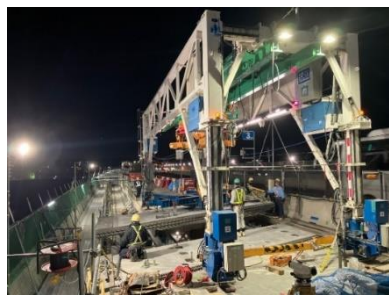
(床版取替施工状況)
