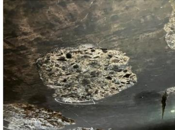
(覆工コンクリートの熱による劣化状況)
