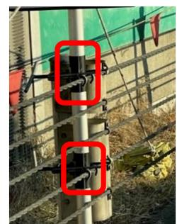
(規制標識支柱の変形状況)
