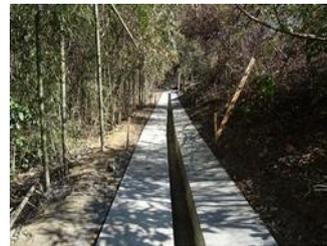
(のり面排水構造物の改良（通水阻害対策、先掘防止）)
