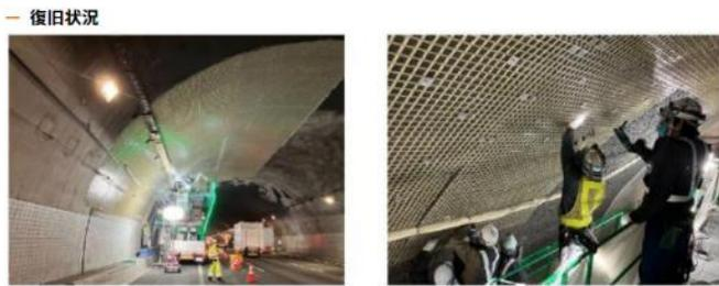
火災で損傷したトンネル覆工コンクリートの補修作業
