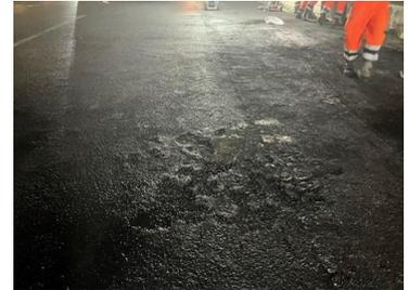
(舗装の熱による劣化状況)
