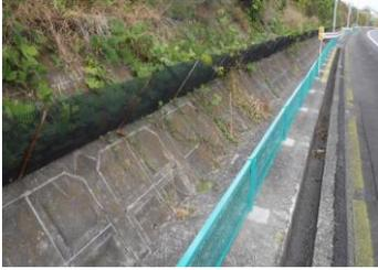
(新設した簡易的落石防止柵 (右側))
