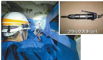
(き裂近傍の ICR 処理によりき裂を閉口)
