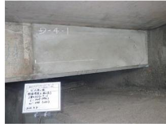
(判定区分Ⅲ：桁端部塩害劣化の補修後)
