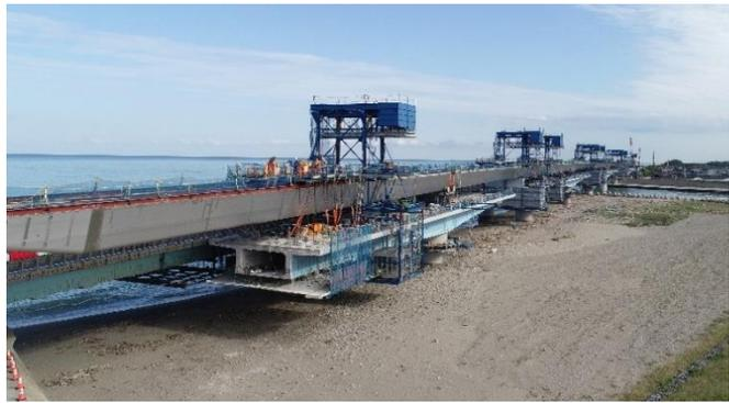
(新設桁を活用した既設桁の撤去状況)
