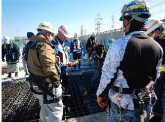
(建設労働災害の専門家による鉄筋組立作業の点検)
