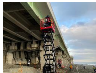
(西湘バイパス 滄浪橋における高所作業車を使った塩害等による劣化状況の取材)
