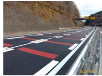
(カラー薄層舗装 (中央道 多治見 IC～小牧東 IC))
