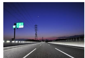
(本線路肩部に設置されている「低位置照明」)
