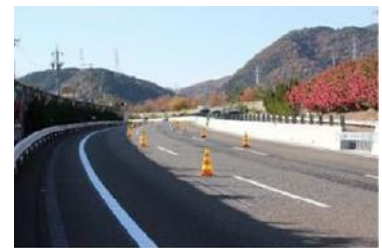
（左側路肩拡幅状況）
