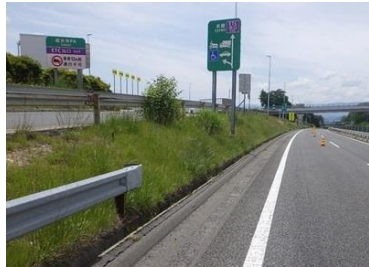
(切土のり面に設置されている休憩施設案内看板)
