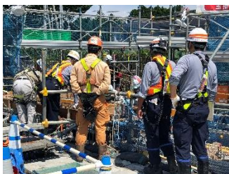
(建設労働災害の専門家による 仮設足場の点検)
