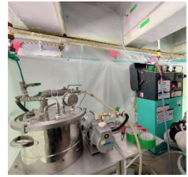
(グラウト注入不足箇所の補修（再注入）の試験施工状況)
