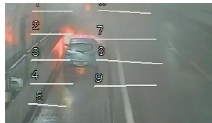
(トンネル内の水噴霧装置の稼動)
