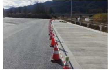
(ダブル連結トラック優先駐車マスの整備)
