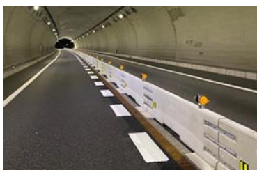
(トンネルへのセンターブロックの設置)
