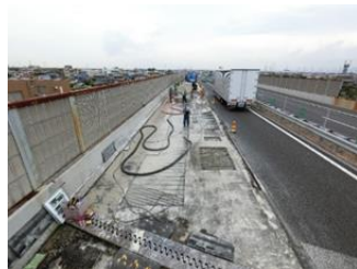
(橋梁床版補修)
