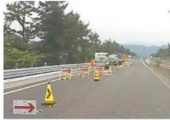
(はみ出し規制区間でラバーコーンへの矢印付カバーを設置して視認性を向上)
