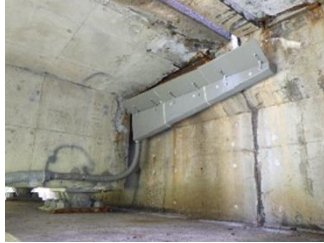
(伸縮装置からの漏水防止 (導水設備の設置))
