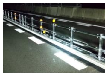
(長大橋へのセンターパイプの設置)
