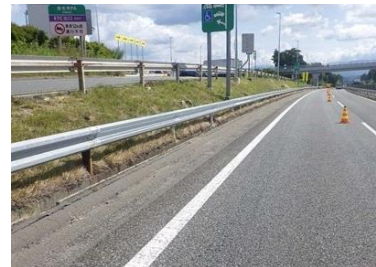
(休憩施設案内看板の前にも防護柵を設置)
