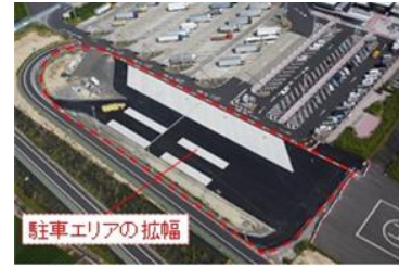
(休憩施設の駐車エリアの拡幅状況)
