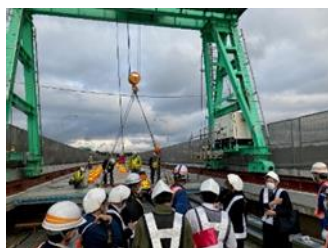
(中央道 多摩川橋における床版取替状況の現場公開)
