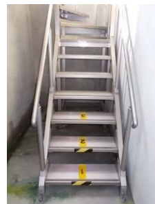
(階段の全体写真)
