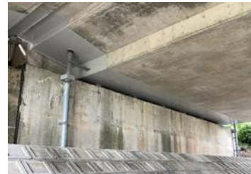
（判定区分Ⅲ：桁端部塩害劣化の補修後）
