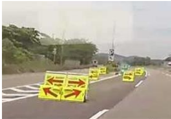
(規制テーパー部で二段矢印板を設置して視認性の向上)
