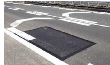
(試験施工後 60 日経過した状況)
