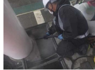
(洗浄状況 (トールゲート柱脚部))
