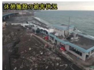
（台風 19 号による被害状況）
