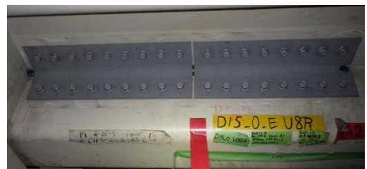
（当て板補強後）
