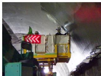
(トンネル覆工補修)
