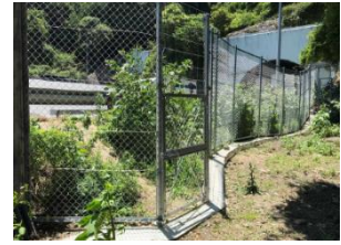
(立入防止柵の下にコンクリートシールを敷設)
