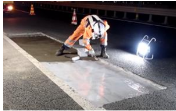
(「ハイウェイ・スラブボンド」の施工状況)
