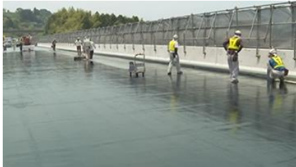
（高性能床版防水工）
