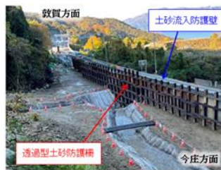
(2車線確保のための 土砂再流入対策)
