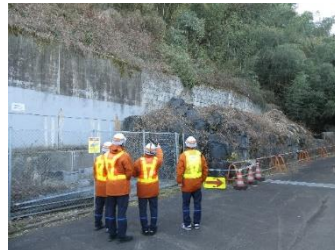
(現場確認状況)
