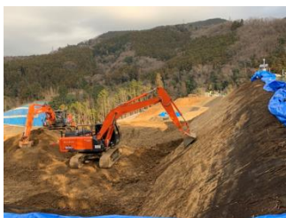
(マシンガイダンス 15 によるのり面掘削)
