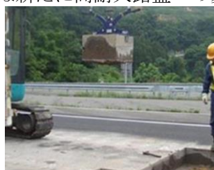
(開削調査の状況)
