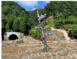
(敦賀トンネル（下り線） 南坑口土砂流入状況)
