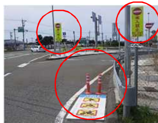
（路面標示やラバーボール設置事例）
