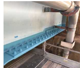
(判定区分Ⅲ：橋梁の桁端部の補修後)
