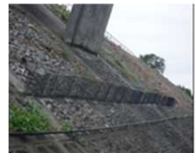
(砂利落下防止ネットの設置)
