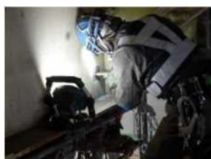
(き裂近傍の衝撃処理によりき裂を閉合)
