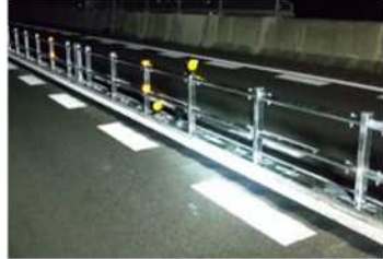
（長大橋へのセンターパイプの設置）
