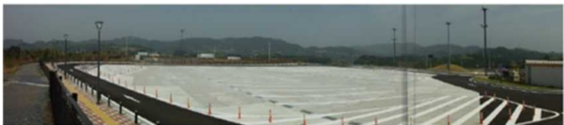
(増設した新東名高速道路 浜松 SA の大型車駐車場)
