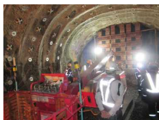
(高度専門技術研修(トンネル)の現場研修)
