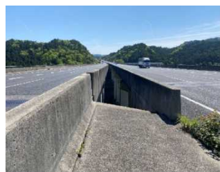
(中央分離帯の橋台部の開口部)
