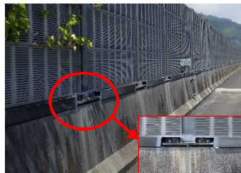
(通常の遮音板の最下段部の点検口)
