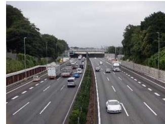
(大和トンネル付近拡幅工事 一部運用後)
