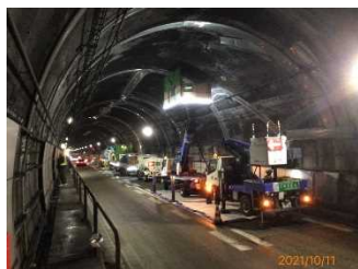
(トンネル覆工補強)
