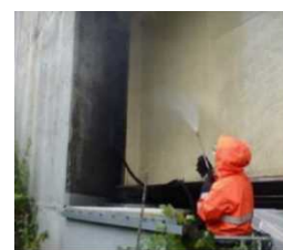
(付着塩分を除去するために橋桁端部を洗浄)
