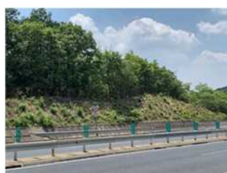
(切土のり面1段目の植樹伐採)
