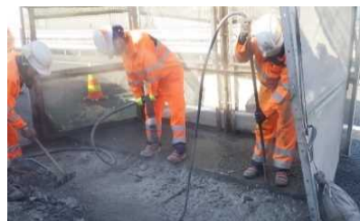
（コンクリートブレイカーを用いた作業）
