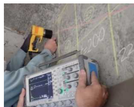
(インパクトエコー法の計測状況)
