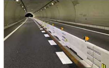
（トンネルへのセンターブロックの設置）
