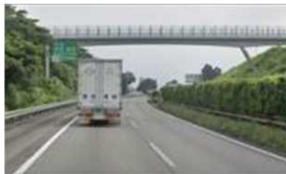
（カーブのため規制設置が危険な箇所）
