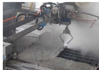
（自動化したウォータージェットによるはつり作業）
