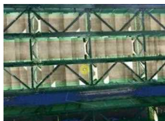
(ワイヤー吊下げ式ロボットによる撮影) (取得した画像を3次元モデル化) (ひび割れ幅ごとに自動に色分け)
