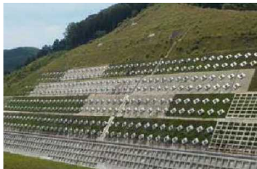
(地すべり対策の代表的な工法のグラウンドアンカー)
