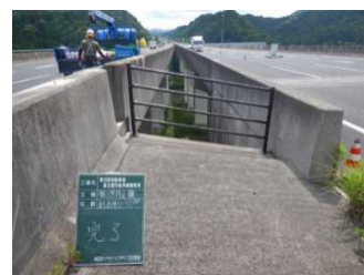
(開口部に設置した転落防止柵)
