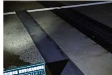
（段差補修を実施）
