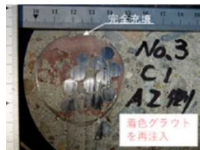
(PC グラウトの再注入後の断面)
