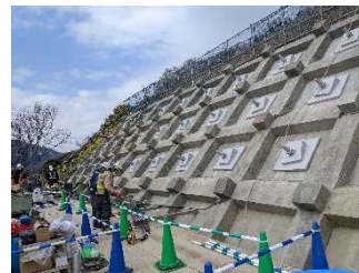
(グラウンドアンカー補強)
