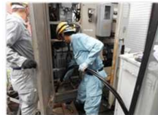
（受配電設備・幹線ケーブルの更新）
