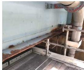
(判定区分Ⅲ：橋梁の桁端部の補修前)
