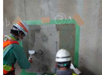
(ゲル状の亜硝酸リチウムの塗布状況)
