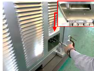
(基礎部の点検が可能な状態)
