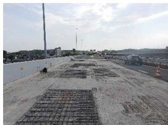
(橋梁床版補修)
