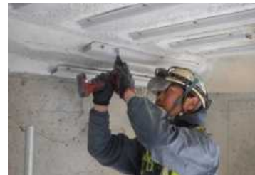
（陽極ユニットの取付状況）
