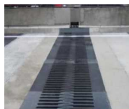
(鋼製大型伸縮装置の取替え)
