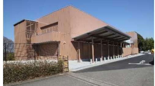
（八王子支社敷地内に整備した「安全啓発館」）
