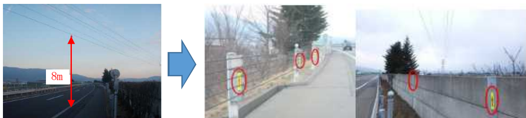
（高速道路上空の送電線）
