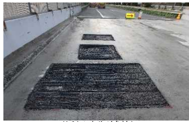
(橋梁床版補修)
