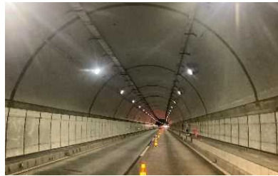
(トンネル覆工補強)
