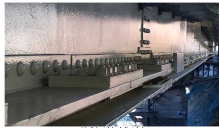
(橋梁桁補強)
