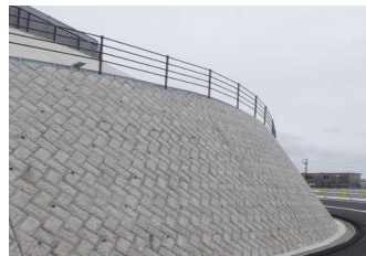
(ブロック積の上の転落防止柵)
