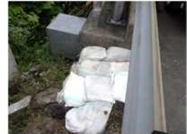
（土のうによる陥没の応急復旧）
