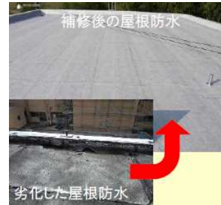
（建物延命化の一例：屋根防水の更新）
