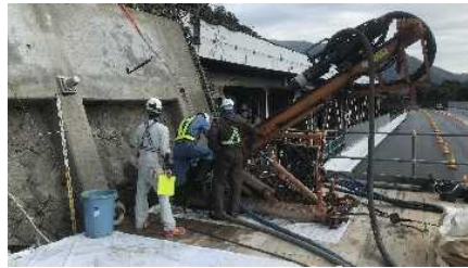
(グラウンドアンカー補強)
