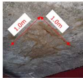
（橋梁の床版下面の変状）
