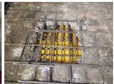
（変状箇所を除去した床版）
