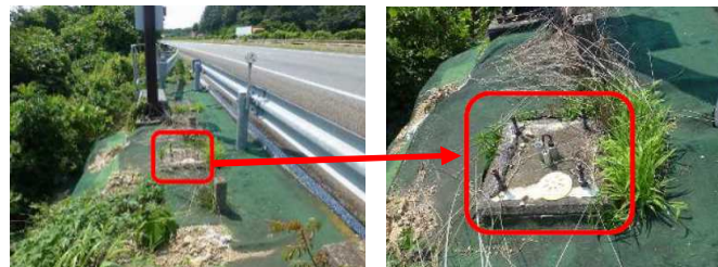
(道路附属設備の撤去後に残された基礎とアンカーボルト)
