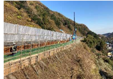
(中央道 小仏トンネル付近(上り線))
