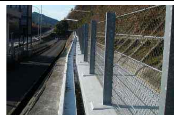
(止水壁を設置した小段排水)
