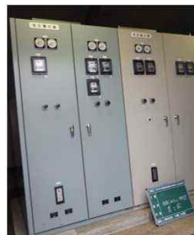
(受変電設備更新 左：更新前、右：更新後)
