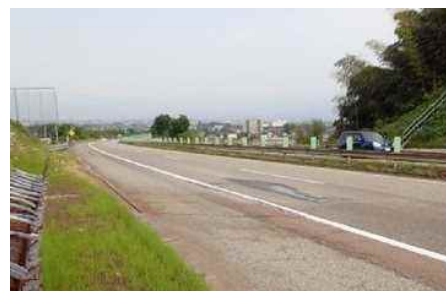
(路面からの湧水発生状況)
