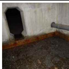
(箱桁内の滞水)
