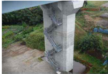
(橋梁点検階段)
