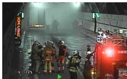
(水噴霧装置の稼働)
