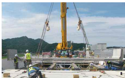
（プレキャスト床版の設置状況）
