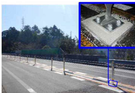
(ワイヤロープ [橋梁部])
