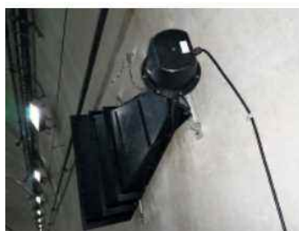
(トンネル専用スピーカー [左：設置状況、右：反響が少ない仕組み])
