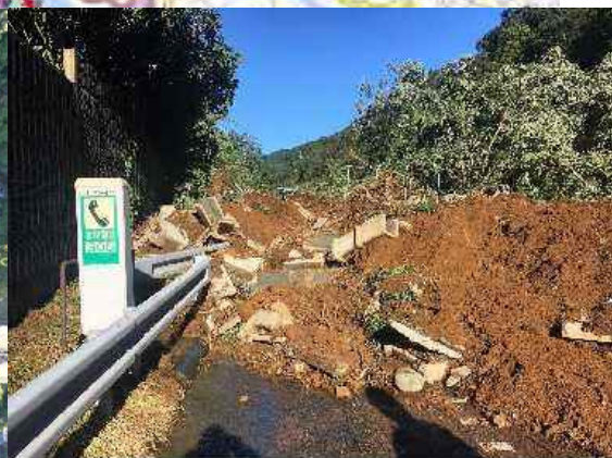
(中央道(上り線)43.6KP付近)
