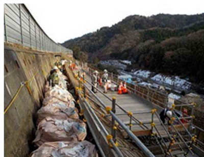
(中央道 小仏トンネル付近 (上り線))
