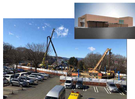
(建築中の「安全啓発館」)
