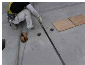
（間詰部（目地）の状況）
