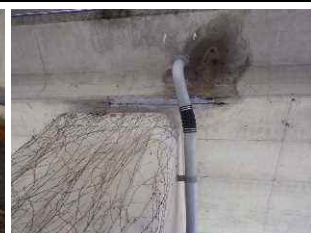
(水抜き穴から劣化が進行)
