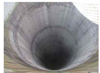
(トンネル換気塔内部)
