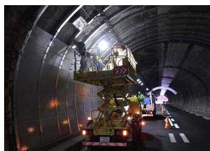
(覆工補強工事〔トンネル〕)
