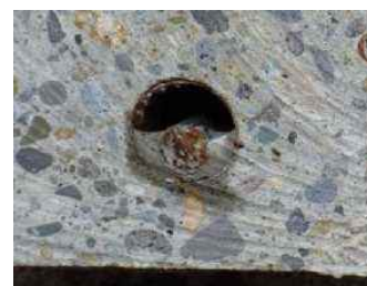
(PCグラウトの充填不足)
