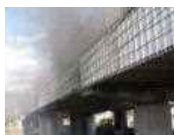
(桁下足場内の火災)
