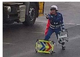
(矢印板設置時の作業)
