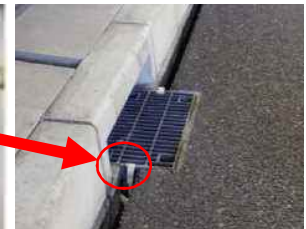
(排水マスの固定状況)
