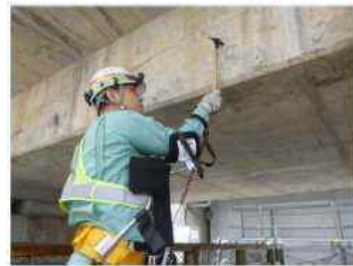
（打音点検での使用状況）
