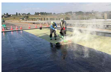
(高性能床版防水工事〔橋梁〕)
