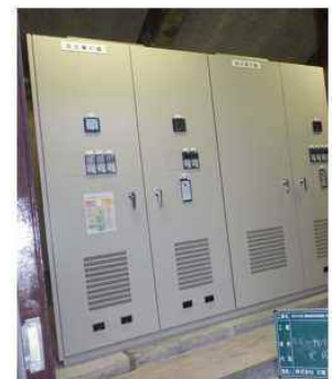
(受変電設備更新 左：更新前、右：更新後)
