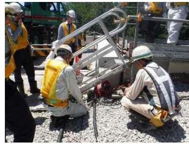
(専門家による現場点検)
