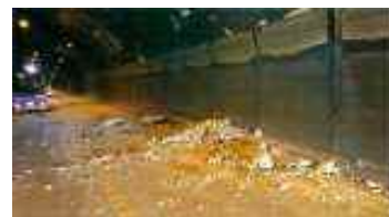
(奈良県HP/芦原トンネル覆工のはく落状況)
