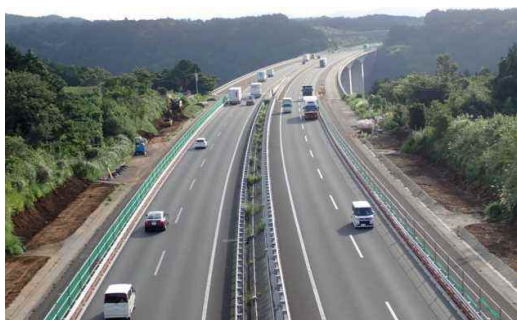
(新東名高速道路 6車線化工事)
