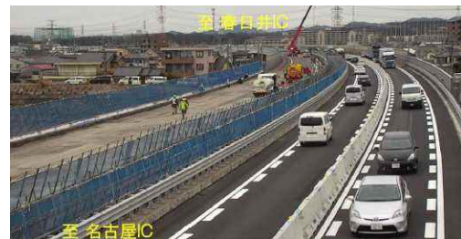
(床版取替え工事現場)
