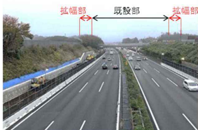
(東名高速道路 大和トンネル付近)
