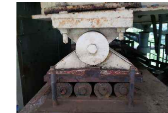
(ローラー支承補修〔ケレン作業中〕)
