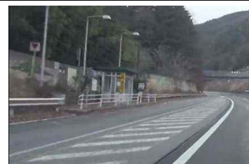
(ガードパイプ設置の事例)
