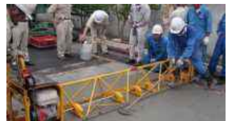
(超高強度繊維補強コンクリートの打設試験)
