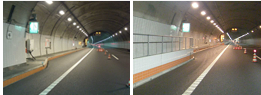
【東海環状自動車道 猿投山トンネル(外回り)】
