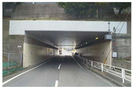
【剥落対策工(連続繊維シート)施工後】
