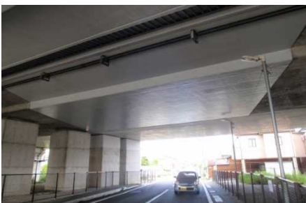
【剥落対策工(連続繊維シート)施工後】
