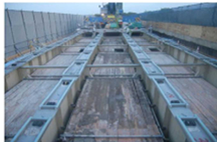
《床版撤去状況》
