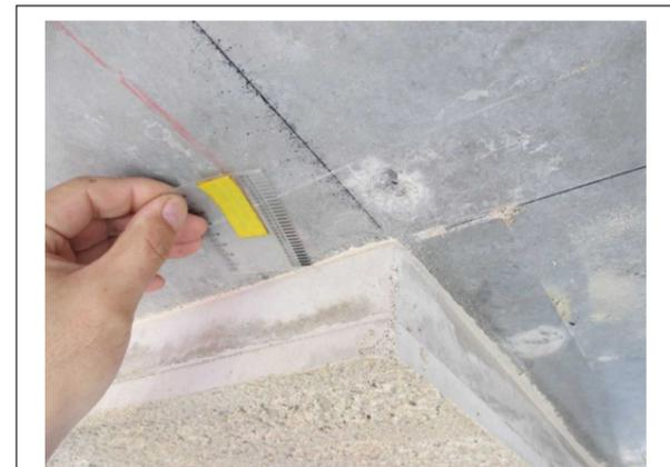
測点 5 の写真 (隙間なし)
