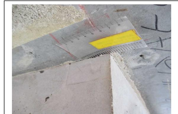
測点 5 のはく離状況の写真 (隙間 0.3mm)
