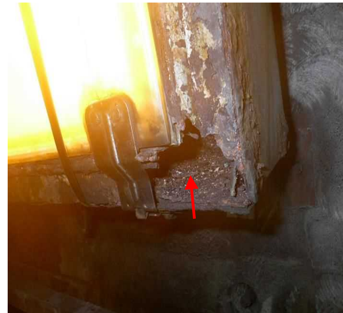
【資料３より】 灯体が「ＳＰＣＣ」の場合の変状 （取付脚周辺の灯体に穴が開いた状況）
