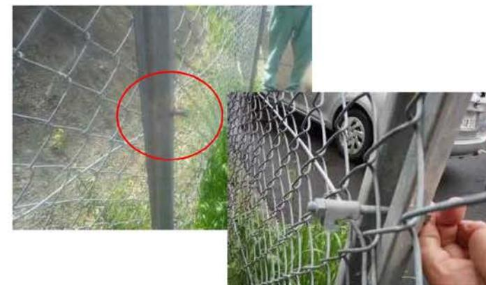
ボルトの締付け不良
