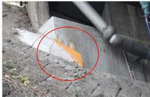
ブロック積端部の型枠が残置
