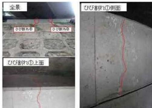
図 1 緑橋A1橋台にひび割れ
