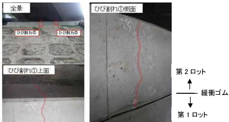
図2 緑橋A1橋台のひび割れの状況
