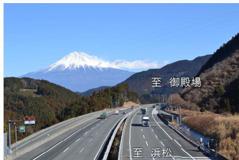
新東名6車線区間
