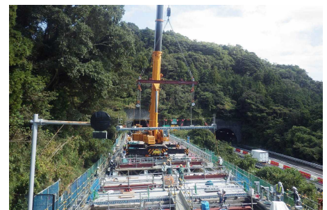
山居沢橋(床版取替): 2021年
