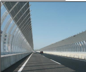
遮音壁（専用部）
