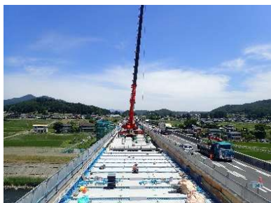
【床版取替工事の様子】
