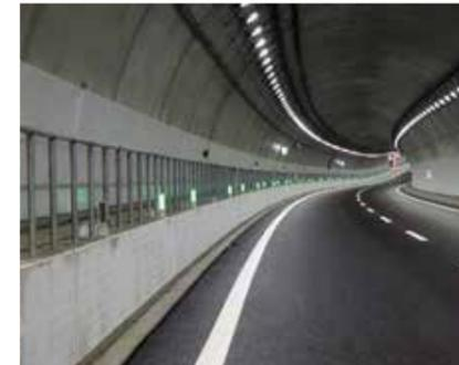
トンネルの設計は写真のような光の流れで速度回復を促す渋滞対策も含まれます。
