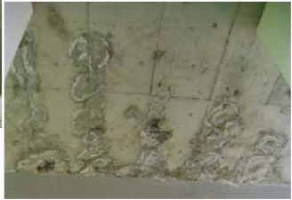
コンクリートのひび割れ、遊離石灰の漏出
