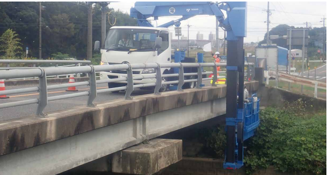
高速道路の橋梁の維持・修繕のノウハウを活かし、一般道の橋梁の点検作業にも取り組んでいます。
