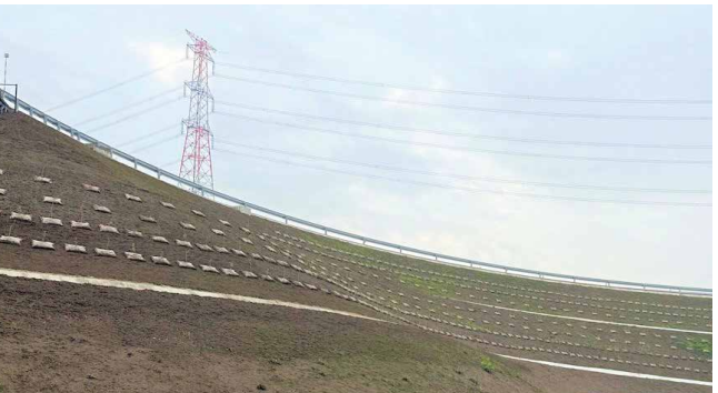
盛土のり面における地域性苗木
