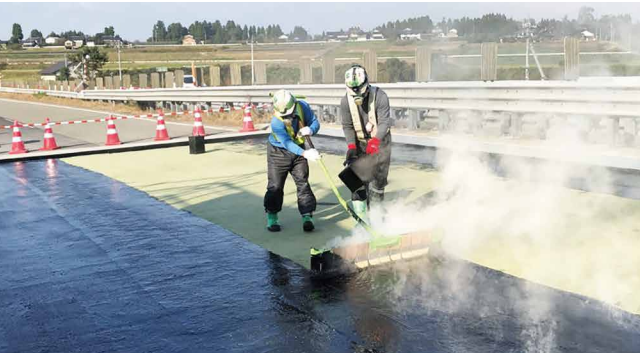
防水工による床版の劣化防止措置
