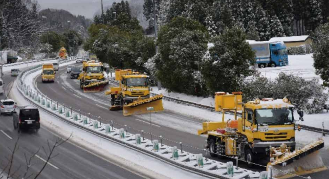
除雪作業の様子(北陸自動車道)
