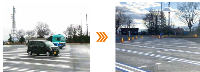
長野道 梓川SA 兼用マスの整備
