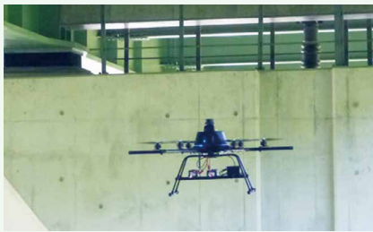
ドローンによる道路構造物の点検
