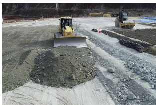
ブルドーザーのマシンガイダンスによる敷き均し
