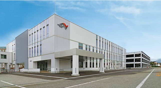
ZEB化対応した富山保全・サービスセンター
