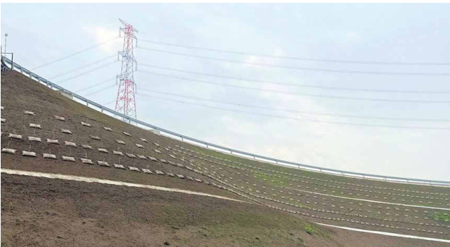
盛土のり面における地域性苗木
