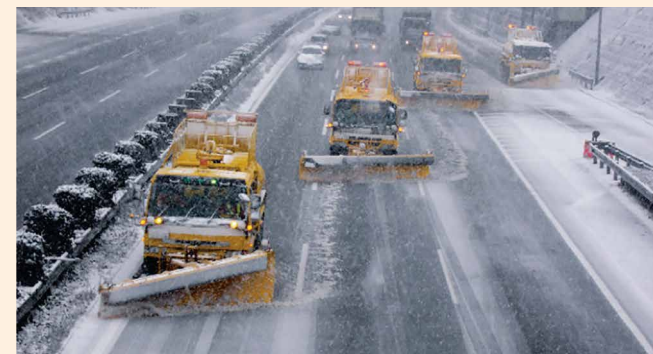
梯団走行による除雪作業
