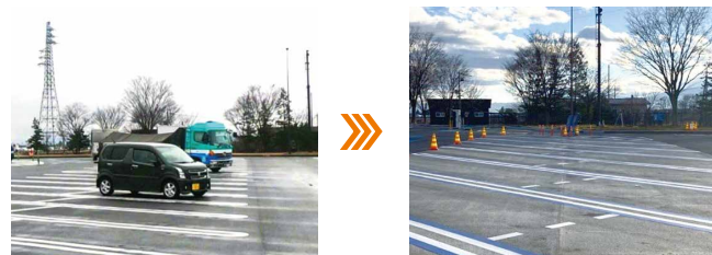
長野道 梓川SA 兼用マスの整備
