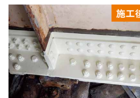
橋梁継ぎ目部からの漏水による鋼板桁端部の腐食に対する鋼橋補修工事
