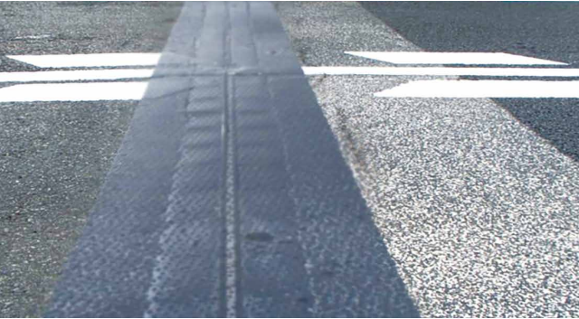
伸縮装置からの漏水対策
