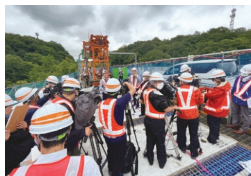
マスコミ向けに床版取替工事の現場を公開
