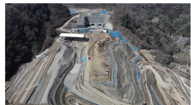
高速道路の建設工事で発生する建設発生土(例)
