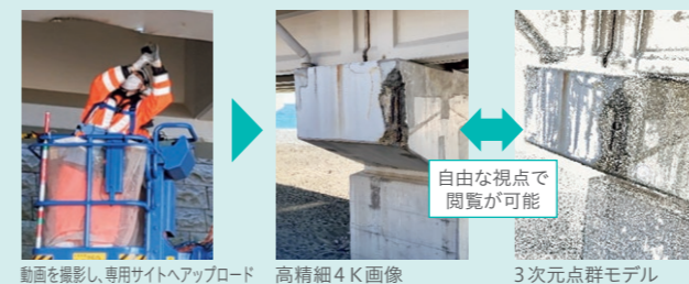
動画を撮影し、専用サイトへアップロード 高精細4K画像 3次元点群モデル 自由な視点で閲覧が可能
