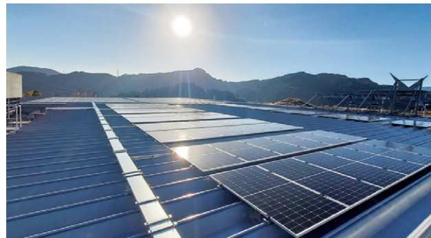
太陽光パネルの設置(清水PA)
