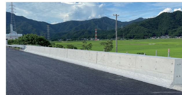
環境配慮型コンクリートの採用事例
