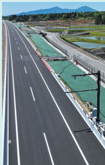
建設中の新東名高速道路の一部区間を活用
