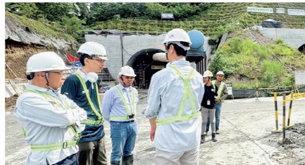
フィリピン国現地法人社員によるトンネル建設現場の確認
