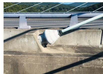
斜張橋ケーブルの定着部
