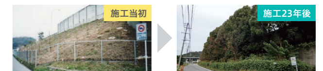
のり面の樹林化の状況
