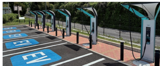
静岡SA(上)に設置したマルチコネクタタイプの急速充電器
