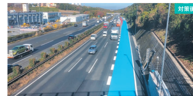
東名高速道路 横浜町田IC(下り線)の加速車線の延伸
