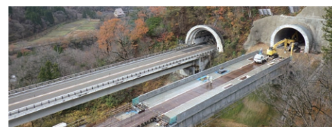
東海北陸道 真木トンネル・北谷橋(富山県)
