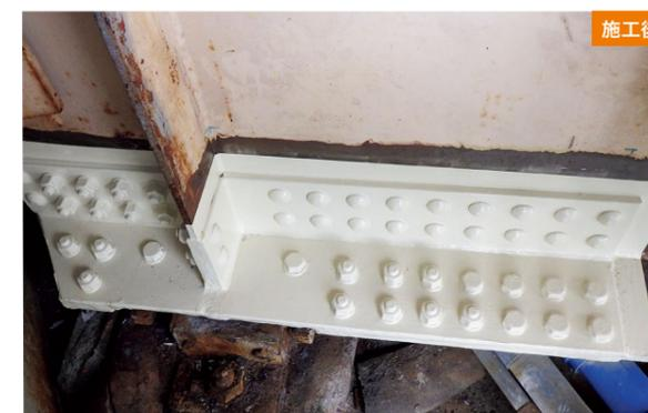
橋梁継ぎ目部からの漏水による鋼桁端部の腐食に対する鋼橋補修工事
