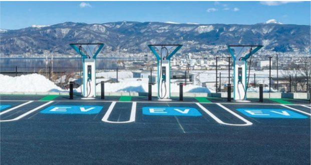
諏訪湖SA(下り)に設置したマルチコネクタタイプの急速充電器
