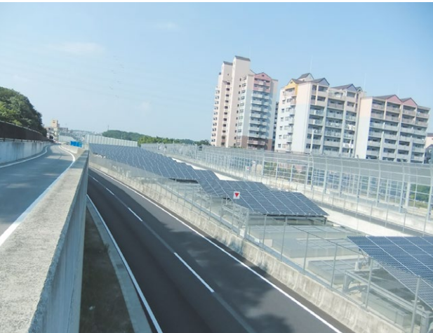
太陽光パネルの設置
