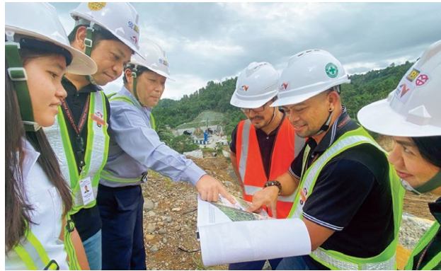
フィリピン現地法人社員とトンネル建設現場の状況を確認
