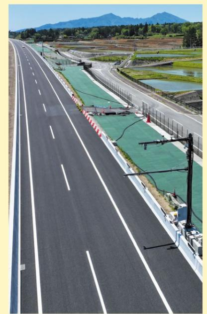
建設中区間の一部を活用した実験区間 (右下は実験用アンテナ等を設置した支柱)
