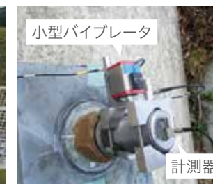
新技術による測定(アンカー頭部)
