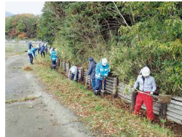
堆積土砂の撤去作業
