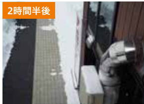
排熱利用融雪システム稼働状況
