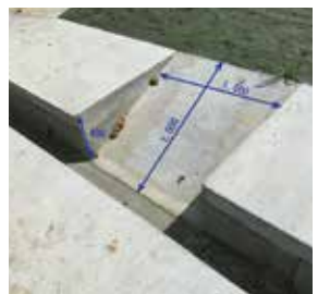
脱出機能を持つ排水路の設置
