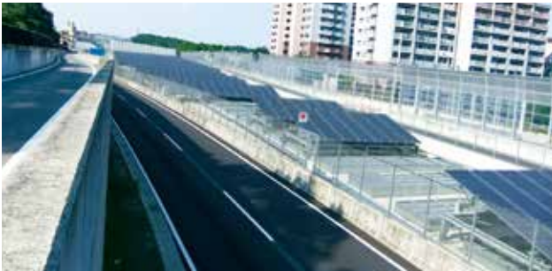
太陽光パネルの設置
