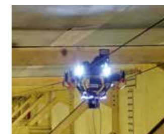
橋内部の狭小部を点検するロボット
