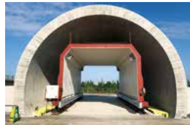
覆工機能を再生する施工方法
