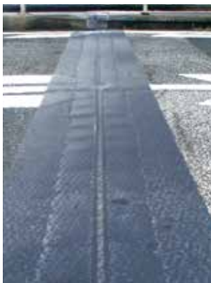
伸縮装置からの漏水対策
