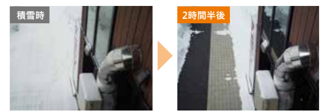
排熱利用融雪システム稼働状況
