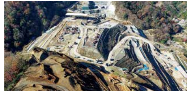
高速道路の建設工事で発生する建設発生土(例)
