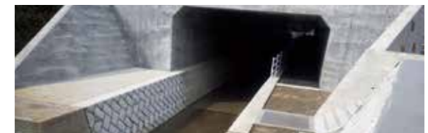
哺乳類の移動に配慮した地下通路
