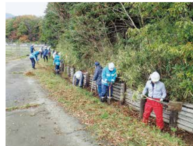
堆積土砂の撤去作業
