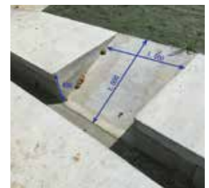
脱出機能を持つ排水路の設置
