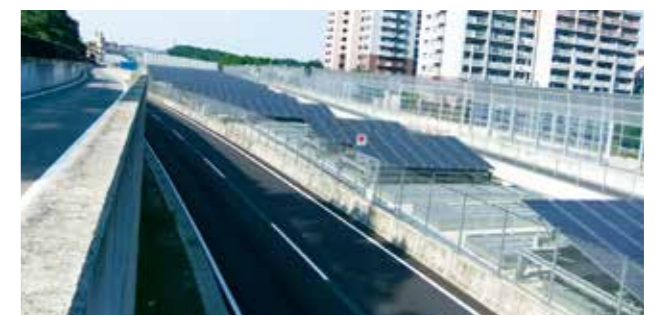
太陽光パネルの設置
