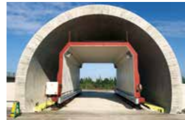
覆工機能を再生する施工方法
