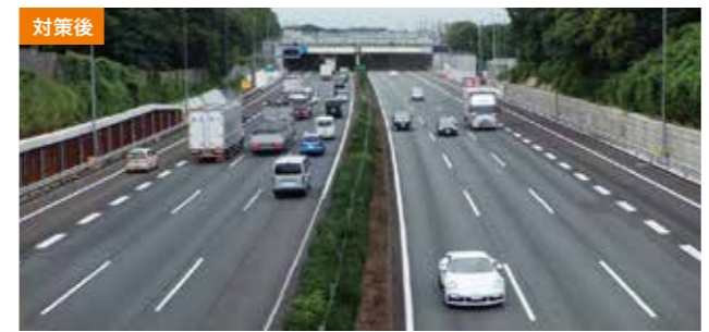
東名高速道路 大和トンネル付近の付加車線設置
