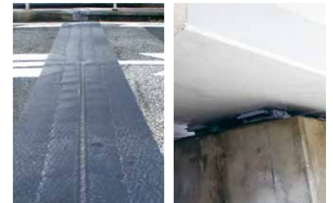
伸縮装置からの漏水対策
