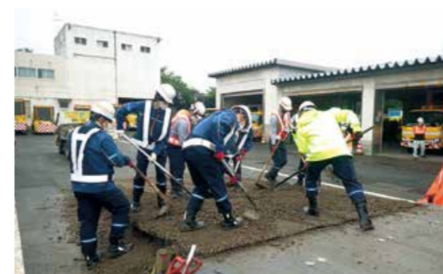
災害時段階解消訓練
