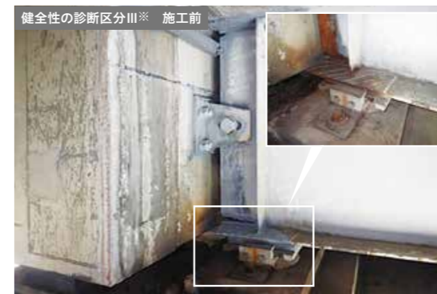
鋼材の腐食対策工事
