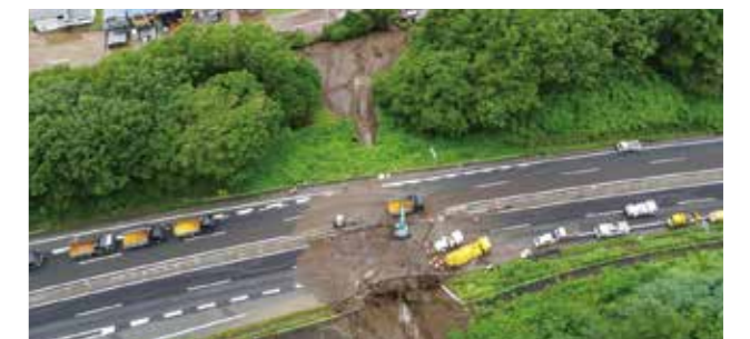
中央自動車道 岡谷JCT～伊北I.C.間で発生した土石流による被災状況(2021年8月15日)
