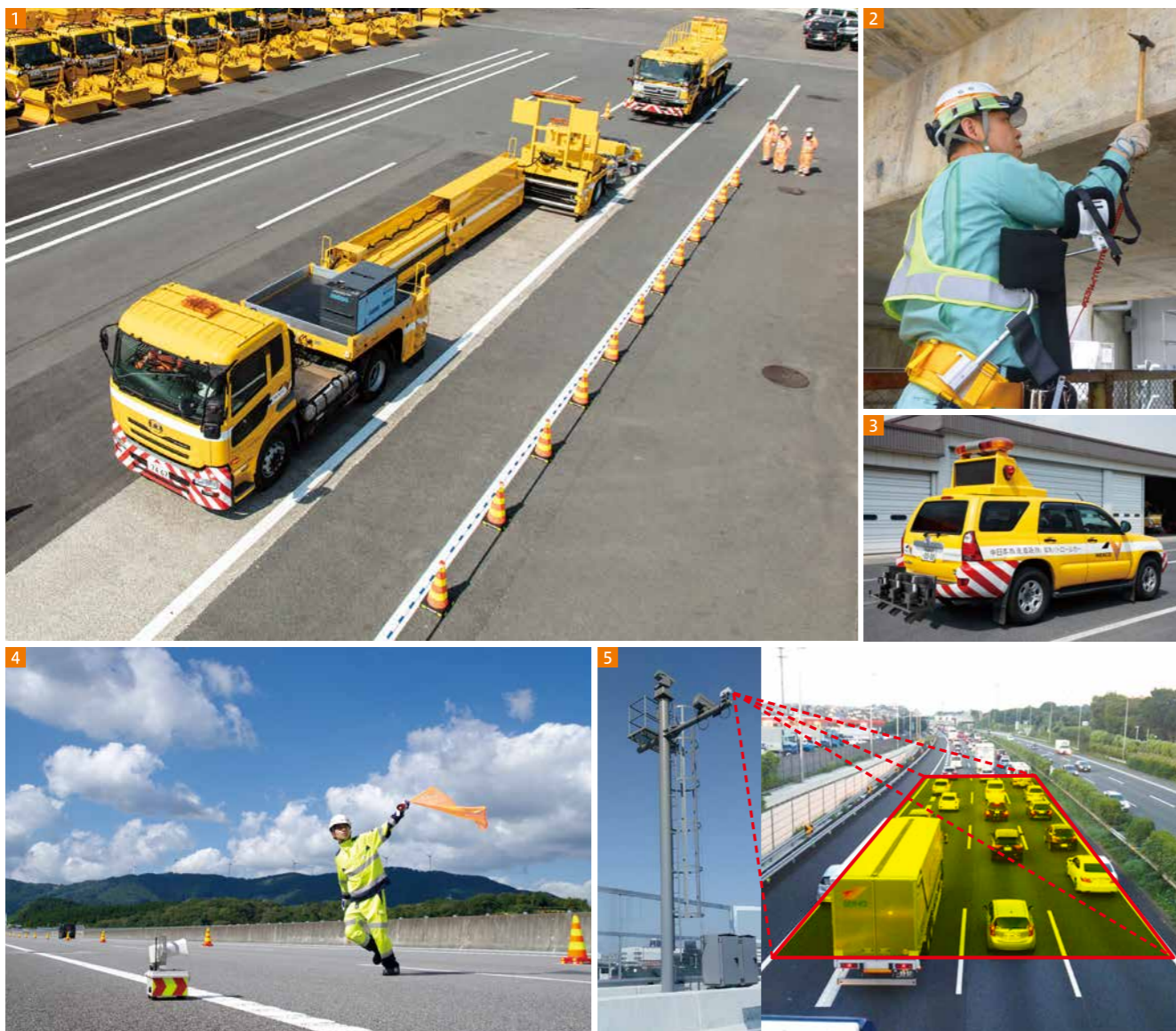
1 大型移動式防護車両 2 点検補助器具「点検楽つく」 3 発炎筒投下装置 4 作業員に危険を知らせる通報システム「NIGERO」 5 ミリ波レーダー交通監視システム
