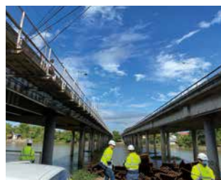
フィリピン国 技術協力 (老朽化橋梁の補修診断)
