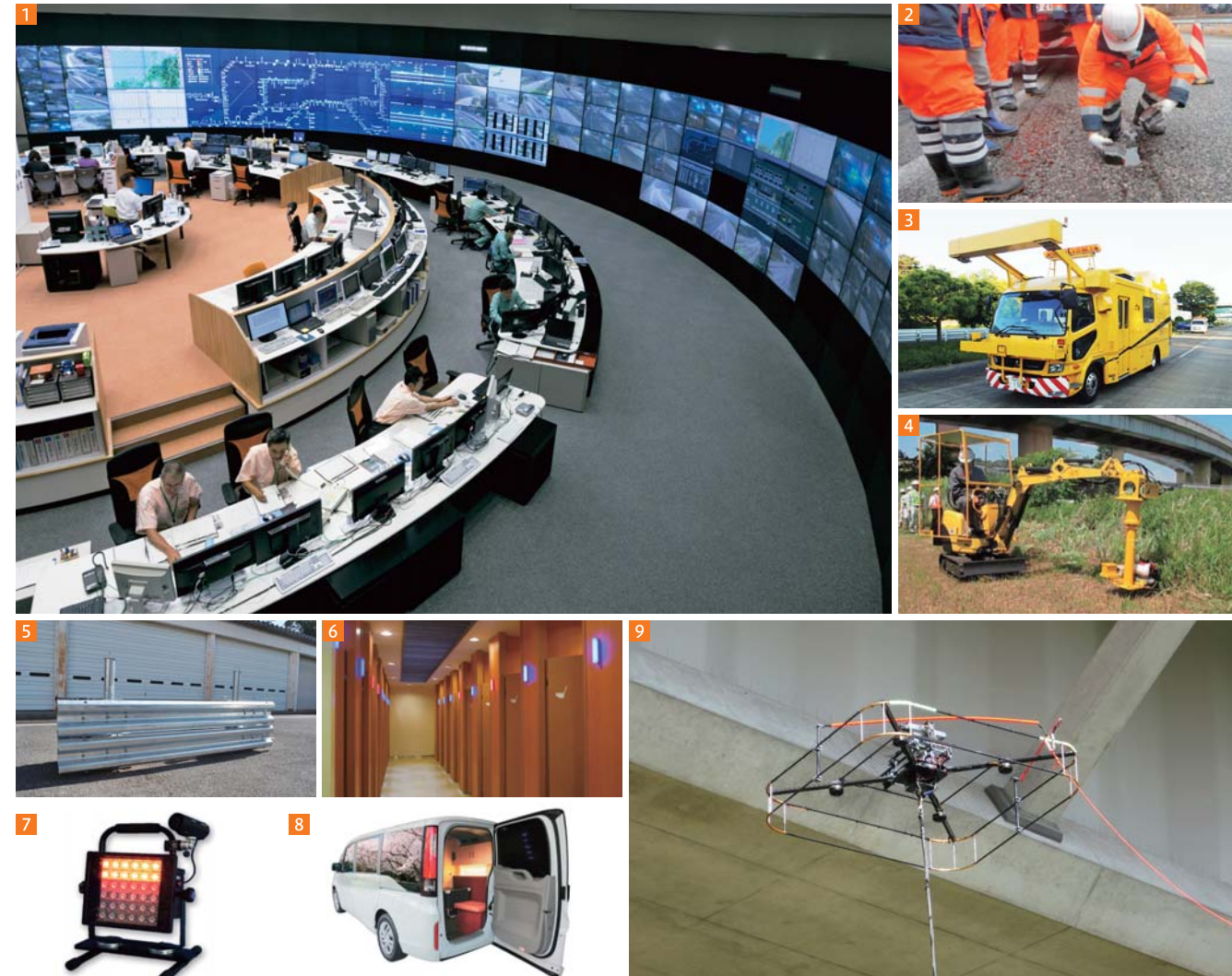
1 道路管制センター 2 全天候型ポットホール補修材 (TOKE・バック) 3 路面性状測定車 (ロードタイガー) 4 機械式トリマー型草刈機 5 人力で着脱可能な開口部用ガードレール (レーンオープナー) 6 利用状況案内システムを有したトイレ 7 超高輝度LED警告灯 (ピカドラ) 8 トイレ、休憩スペースを備えた多機能車両 (サクラ) 9 無人航空機を用いた橋梁点検
