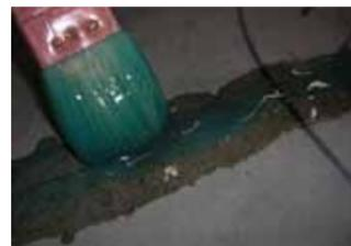
ひび割れ浸透接着剤施工状況
