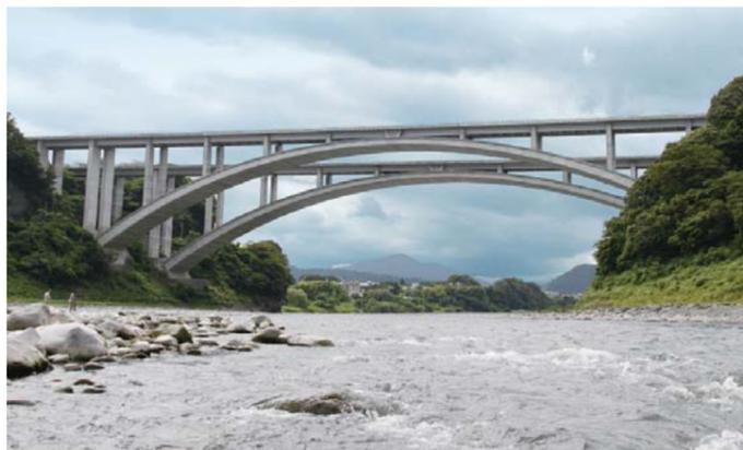
新富士川橋は、一級河川富士川をまたぐ建設当時世界一の支間長265mの長大アーチ橋です。わが国で初めて「鋼・コンクリート複合アーチ橋」を採用しており、アーチ部材・鉛直材の圧縮特性に優れたコンクリート構造と、鋼製の上部桁を組み合わせた合理的な構造で、通常のコンクリートアーチ橋と比べ、重量が約40%軽減され、約20%のコスト削減が可能となりました。
