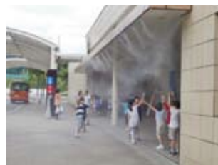
日差し・暑さ対策（噴霧装置の設置）
