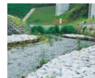
自然型構造護岸（2001年）
