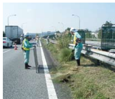
高速道路沿道での草刈り・剪定作業
