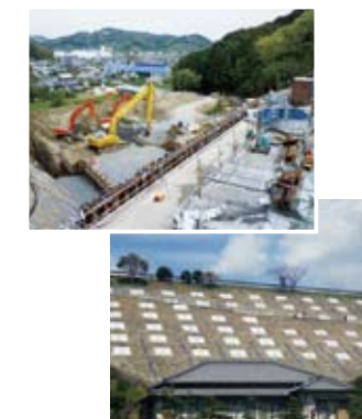
本復旧の状況
