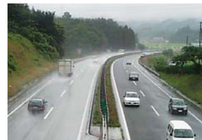
低騒音で、雨降りでも路面の水はけが良い高機能舗装の施工状況（写真右側）
