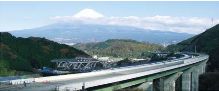
新東名 鑑田沢橋 (静岡県富士市)
