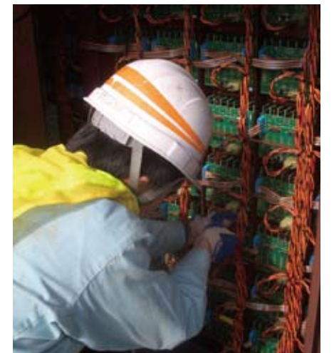
道路情報板の点検
