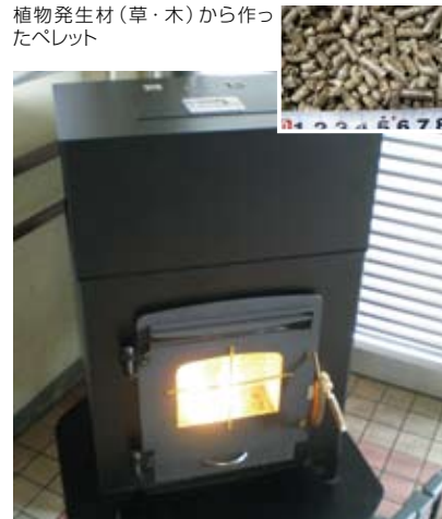
中央道 諏訪湖サービスエリア (SA) の下りに設置した長時間燃焼型ペレットストーブ
