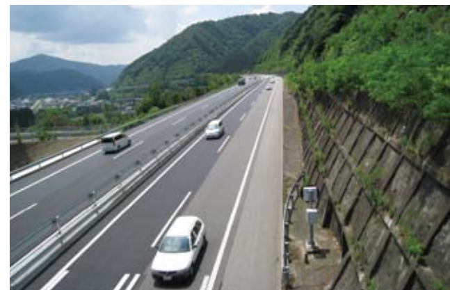
4車線化完成後
