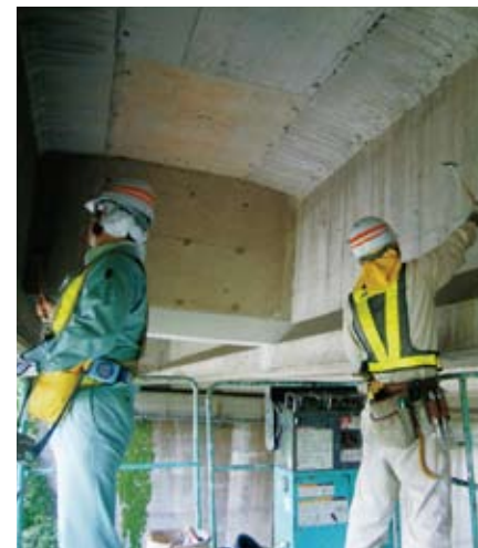
橋梁の安全点検
