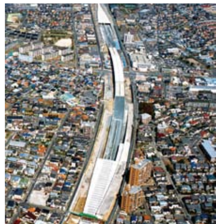
名古屋二環 鳴海IC付近
