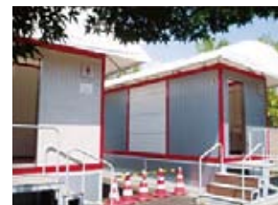
特設トイレの設置
