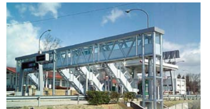
ETCレーン安全通路（中央道 小淵沢IC）
