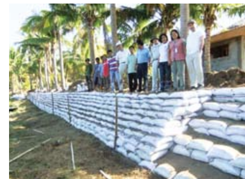
現地護岸整備状況
