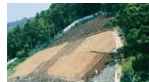
圏央道 八王子ジャンクション（JCT）植栽直後（2000年5月）
