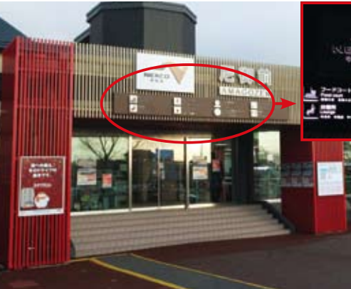
エリアサインLED照明（省エネルギー） エリア名とNEXCOロゴの照明にLEDを使用して省電力化。
