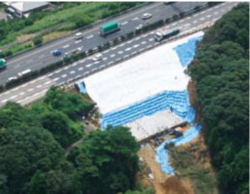
応急復旧後の状況
