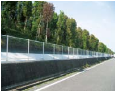
樹林密度の管理をし、のり面の防草対策をした状態（景観にも配慮）
