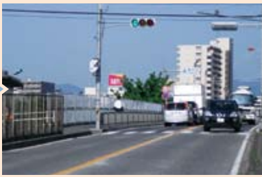
開通後（厚木方面） 5月21日7時頃撮影
