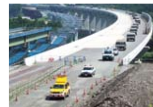
建設中の新東名を利用した 緊急輸送訓練
