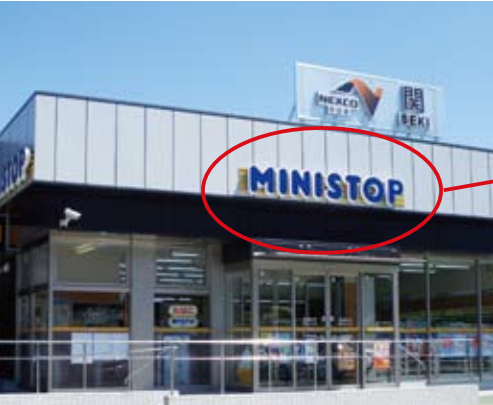
★店舗LEDサイン（省エネルギー） 看板照明へのLED使用により省電力化。（店舗サイン）
