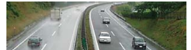
高機能舗装の施工状況（写真右側）
