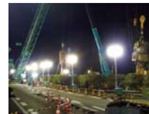
昼夜を徹した復旧作業
