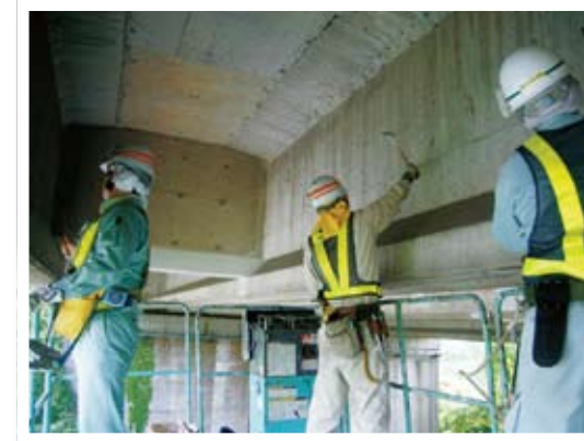
橋梁の安全点検
