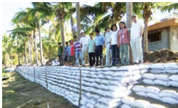
現地護岸整備状況
