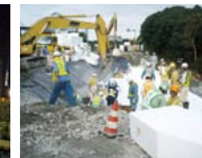
大型重機による復旧作業
