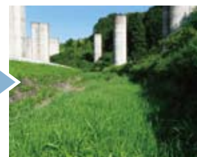
自然型構造護岸（2009年7月）
