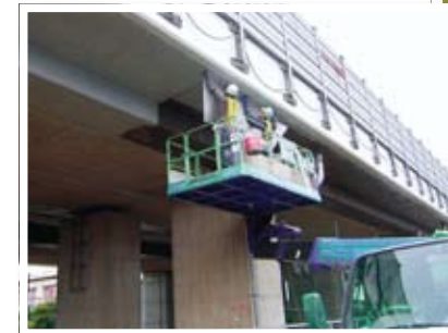
橋梁のはく落防止対策
