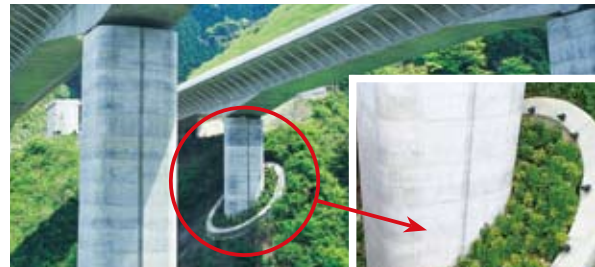
竹割り型構造物掘削工法で施工された橋脚
