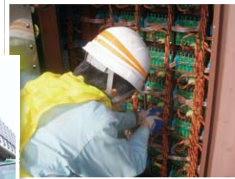
道路情報板の点検
