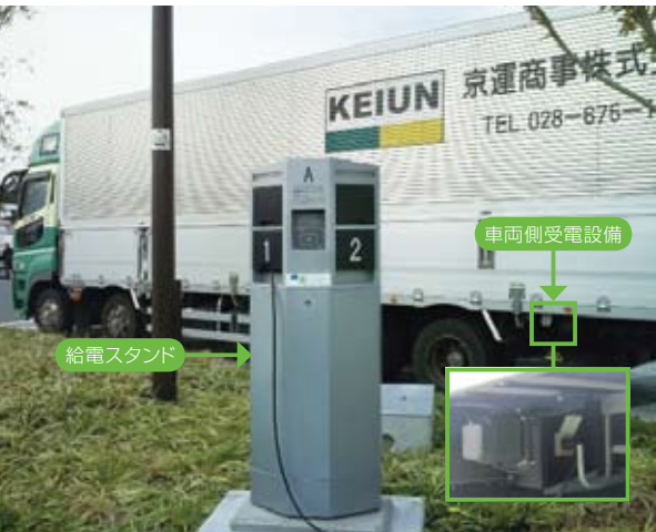
給電システムの試行設置状況（新名神 土山SA）
