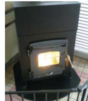
中央道 諏訪湖SA（下り）に設置した長時間燃焼型ペレットストーブ
