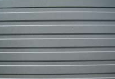
エコ・サイディング（省力化） 酸化チタンにより有害物質（NOx、SOx）を分解し、汚れもセルフクリーニングするサイディングを外壁に使用。
