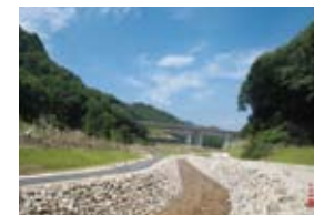
鈴鹿国定公園内の自然型構造護岸
