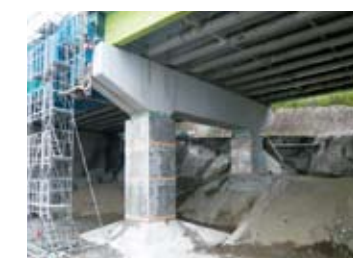
西湘BPの橋脚耐震補強
