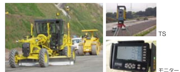
路盤工施工状況
