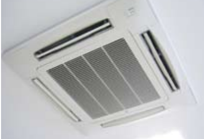
★省エネ空調機（省エネルギー） 空調・冷凍・冷蔵をシステム統合し、消費電力を削減。
